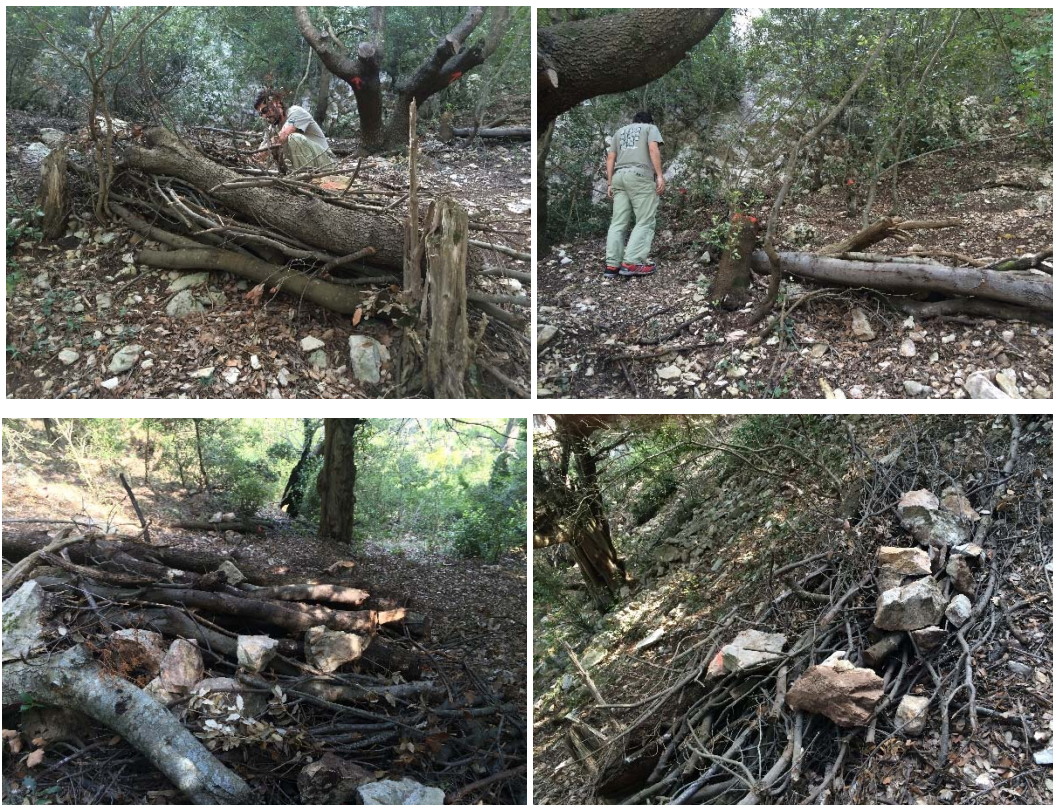
Figura 31. Fajinas para prevenir la erosión de la tejeda madura de Cosp (Serra de Cardó). Se han utilizado los restos de ramaje de los trabajos de regulación de competencia (acciones C1 y C4). Octubre de 2016. Foto: Jordi Camprodon.
